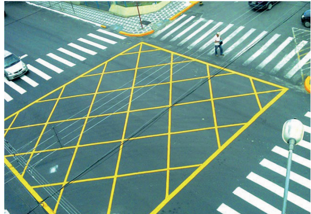
Marcas transversais. Na imagem, marcação de área de conflito e faixa de pedestre são exemplos
