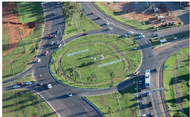
Rotatória, do tipo mista, no Recanto das Emas, no Distrito Federal. Se não estivesse sinalizada, a preferência seria de quem trafegasse pela rodovia.
