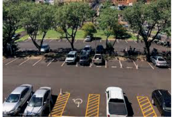
Marcas de canalização e de demarcação de estacionamento
